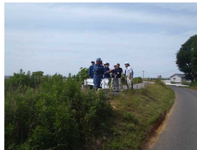
堤防断面不足の箇所を確認
