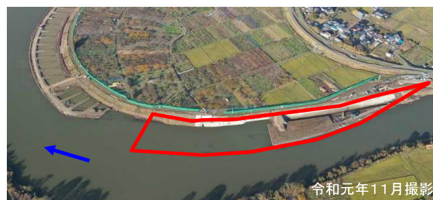
山島新田地区 河道掘削状況
