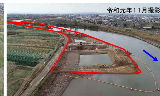
栗林地区 河道掘削状況
