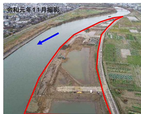
大島地区 河道掘削状況
