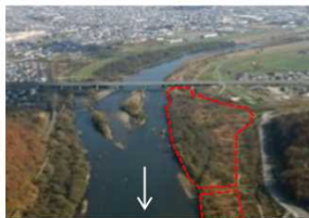
・河道掘削や樹木伐採
