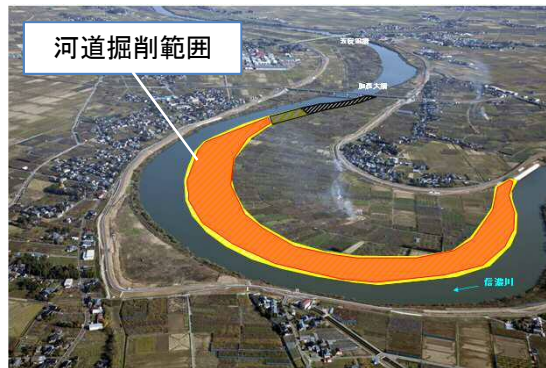
山島新田地区 河道掘削実施状況
