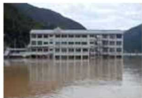
H26. 8 避難所2階の浸水(徳島県)
