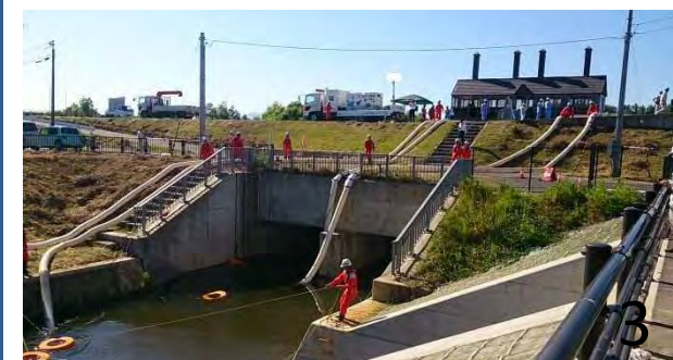
貝喰川排水機場、排水ポンプ車実働訓練
