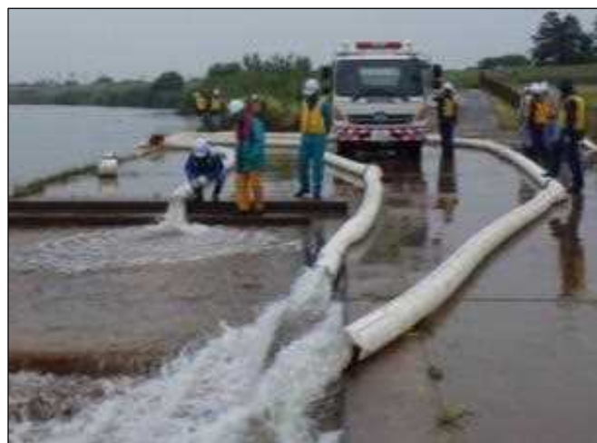
信濃川下流河川事務所職員による排水ポンプ車及び照明車の操作訓練 実施状況
