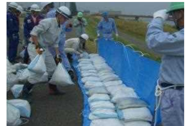
「改良積土のう工」
