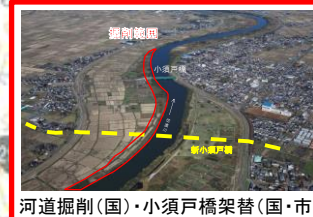
河道掘削(国)・小須戸橋架替(国・市)
