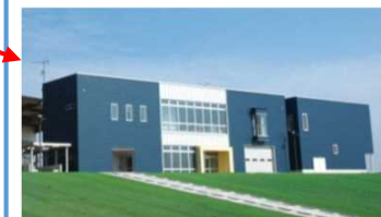
水防学習館と 災害対策車両庫
