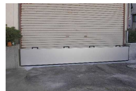
住宅かさ上げ、防水板設置の事例（新潟県新潟市）
