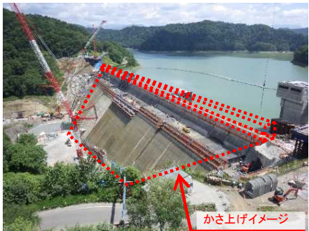
ダム建設・ダム再生
