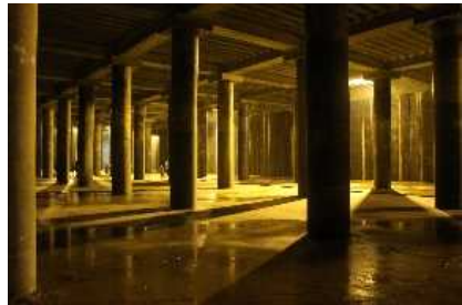
大規模地下貯留施設(下水道)
