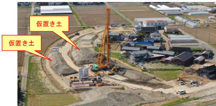
【図-3】 地盤改良施工ヤード全景
