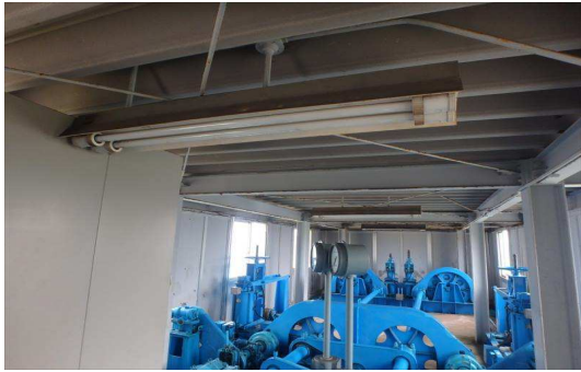
新潟大堰 蛍光灯 (PCB安定器含む) 撤去
