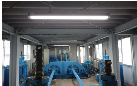
新潟大堰 LED照明器具取付
