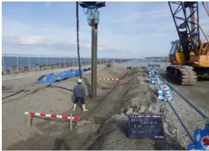
写真5：試し打ち高止まり状況
