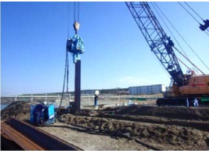
写真2：遮水矢板試掘状況
