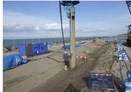
写真6：全周回転式掘削機
