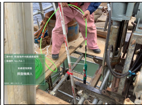
鉛直磁気探査状況
