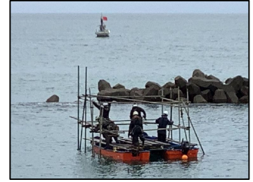
海上足場仮設状況
