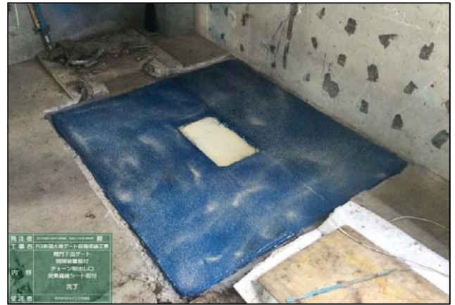
現地敷設状況
