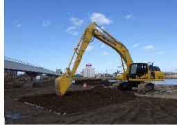
3.施工履歴による精度確認試験状況
