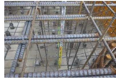
写真5：打設リフト明示鉄筋
