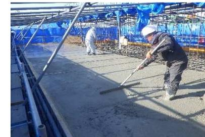
写真11：コンクリート打設
