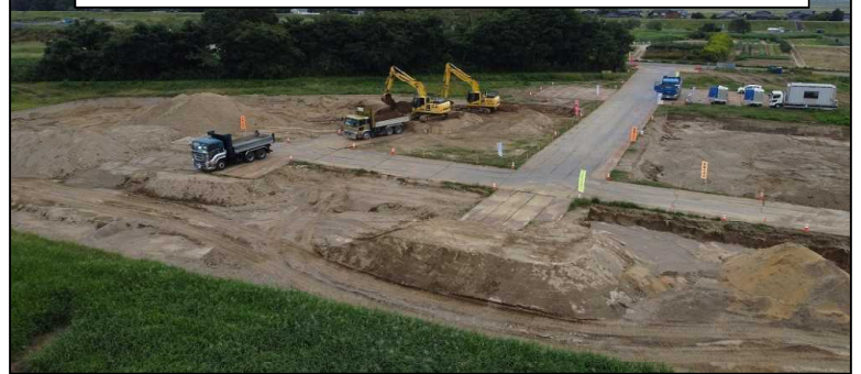
写真②-2 3次元測量による土量確認
