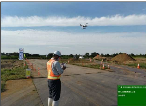
写真②-3 DXアプリケーションによる進捗確認(デジタルツイン構築)
