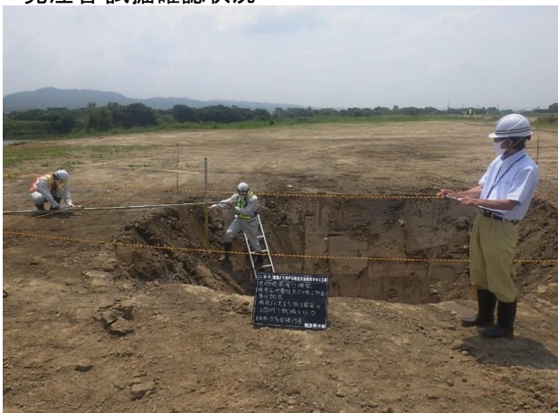
発注者 試掘確認状況
