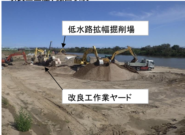
改良土生産、搬出状況
