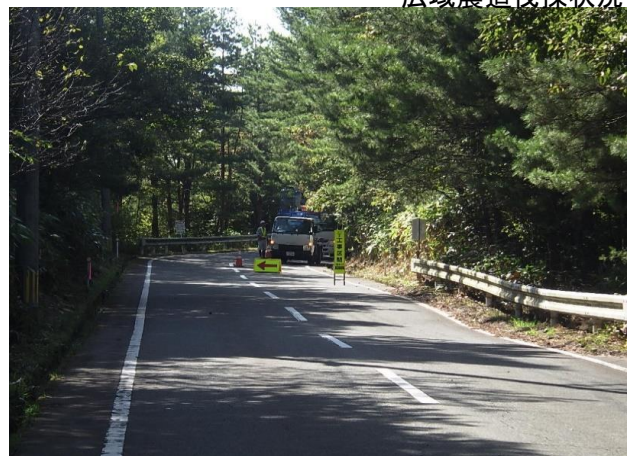
広域農道伐採状況
