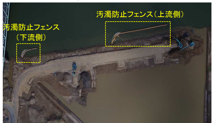
写真①(設置完了近景)
