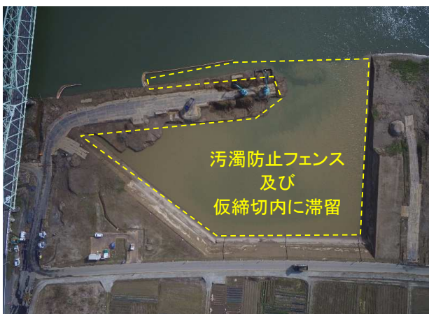
写真②(施工状況) 掘削に合わせて移動済
