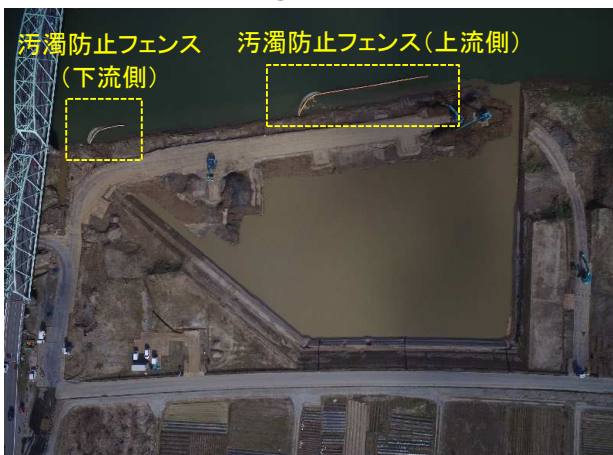
写真①(設置完了)
