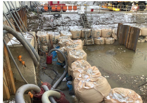
写真-2 1次施工時の排水状況
