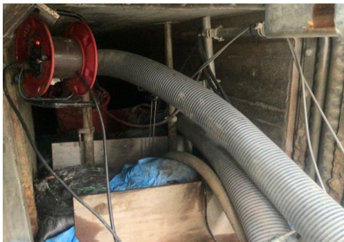
写真-3 2次施工時の排水状況
