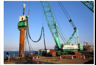
鋼管杭打込み ジャイロプレス工法
