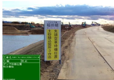
先頭車待機場所看板
