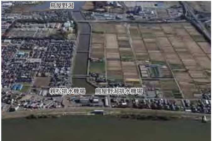
鳥屋野潟排水機場
