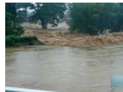
堤防が壊れた刈谷田川
