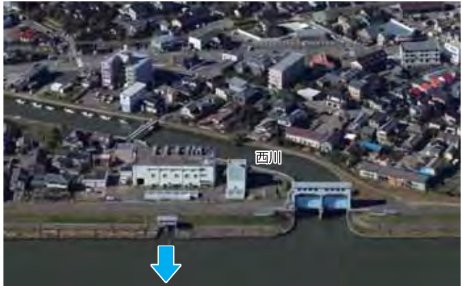
西川排水機場
