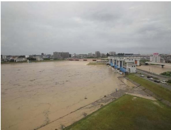
信濃川水門により信濃川への水量の調整
