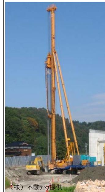
機械攪拌工法は、攪拌翼により原位置土と改良材を混合攪拌し、地中に改良体を造成する工法である。
