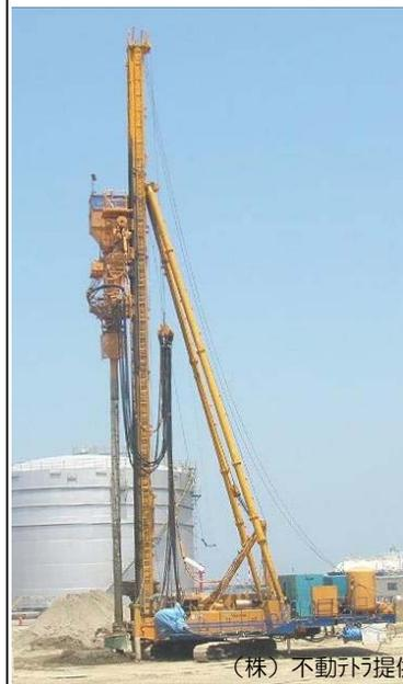
締固め工法は振動、あるいは材料を地盤中に圧入することで、砂地盤の密度増大や地盤の側方拘束を高めることによって、改良範囲内の地盤の液状化強度を高める工法である。
