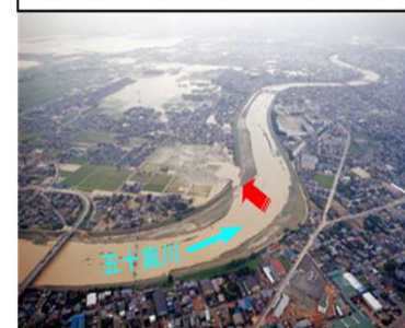
H16.7.13 五十嵐川破堤状況(三条市曲淵)
