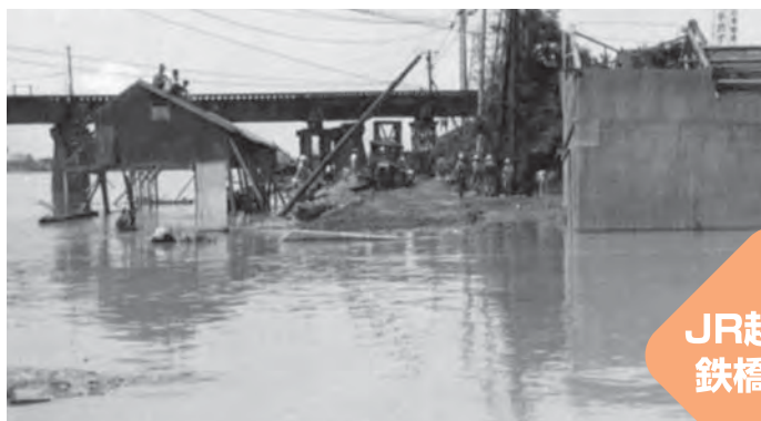
新潟地震直後（地震と津波により流失した堤防）
