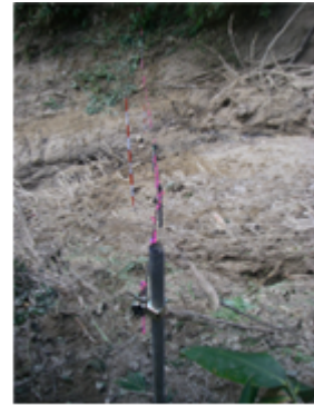
ワイヤーセンサー設置状況
