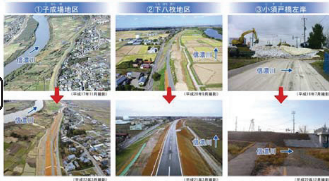
整備前・整備後写真(小阿賀野川から加茂川合流点)
