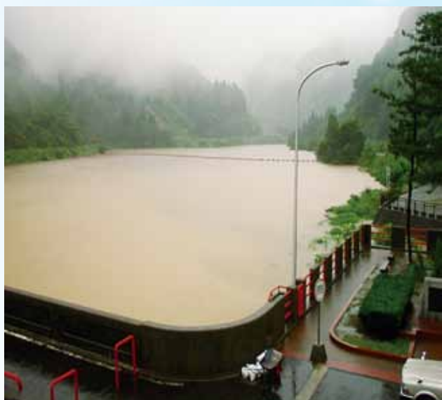
平成16年7月13日豪雨 貯水池状況
