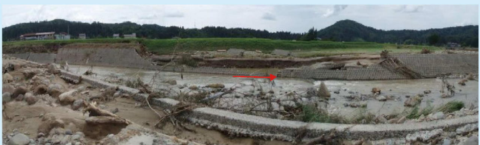
⑪ 堤防欠壊地点の状況(長岡市上塩)
