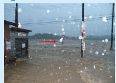
⑥ 浸水により通行不能(長岡市下塩)
