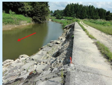
① 堤防欠壊地点の状況(長岡市文納)
