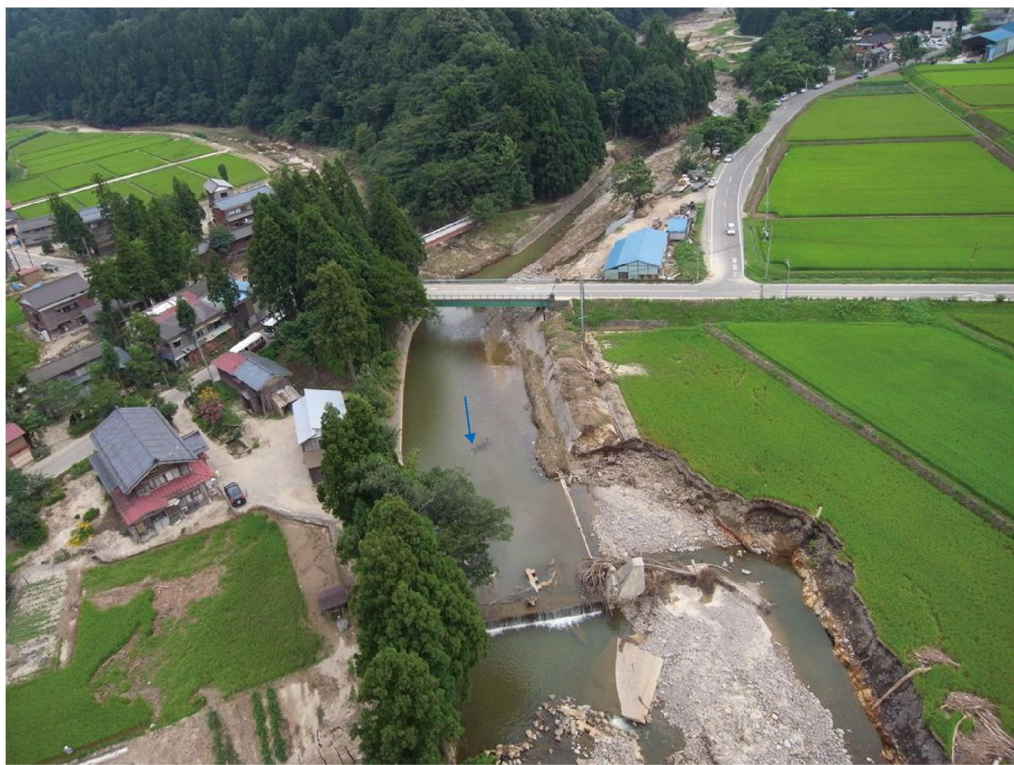
12 河岸浸食の状況（長岡市場新町）
