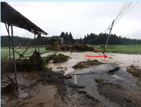
⑧ 浸水による被害状況(長岡市下塩)
