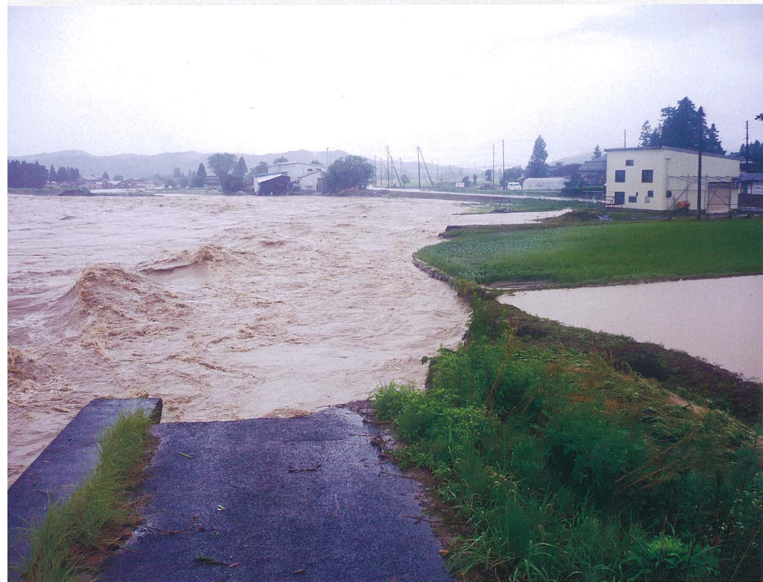
破堤による出水状況 (三条市江口地内)
