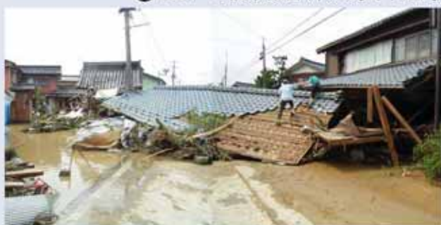
④ 家屋の損壊(中之島町中之島)
