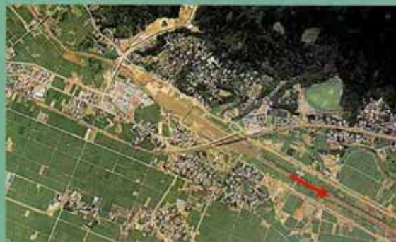
改修途上の能代川(新津市大関・小口 平成7年撮影)
