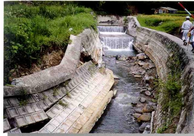
① 河床洗掘によって倒壊したブロック護岸
