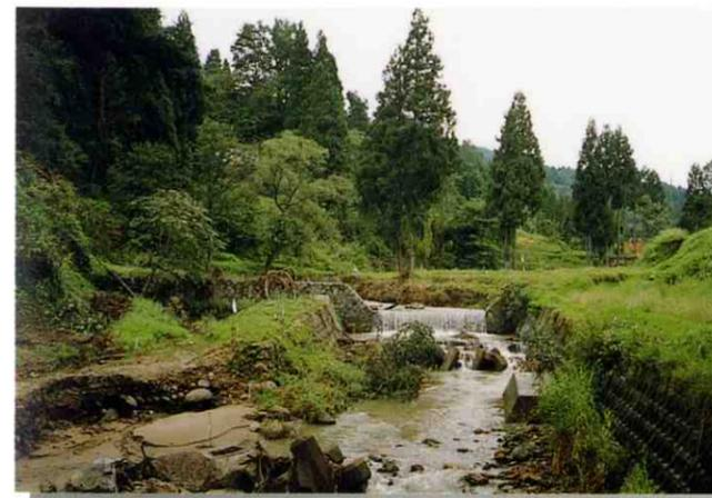
④ 洪水によって流失した護岸と根固ブロック
