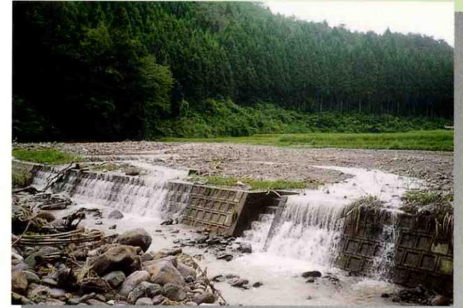
② 河道埋塞により土砂が水田に堆積
