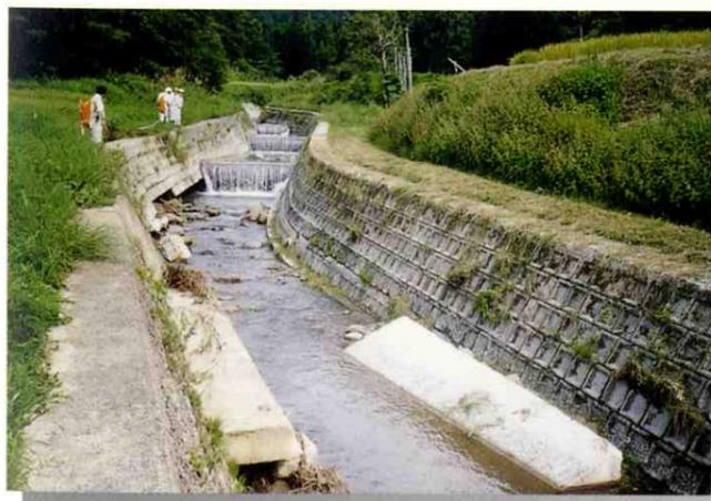
⑤ 河床洗掘によって露出した護岸基礎部
