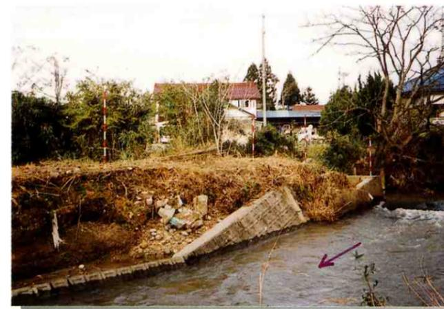
③ 洪水によって被災したブロック護岸 (荒川川)
