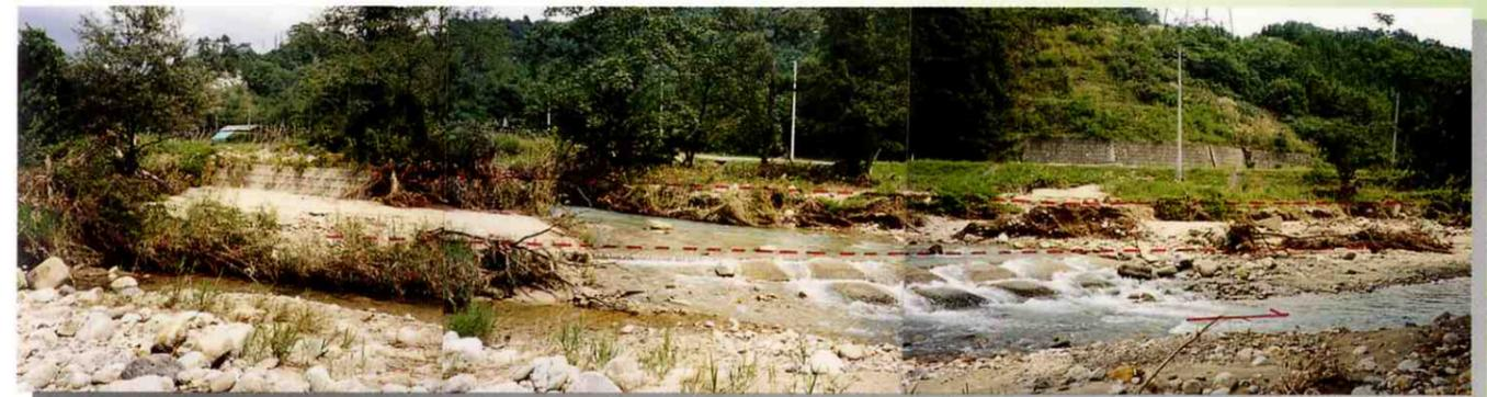
② 洪水によって流失した護岸
