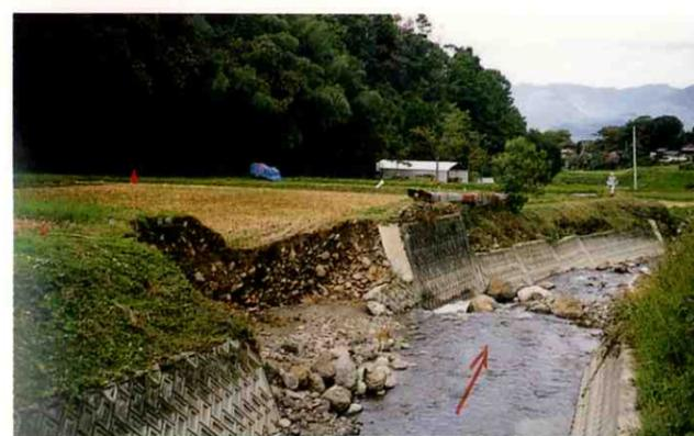
④ 洪水によって被災したブロック護岸
