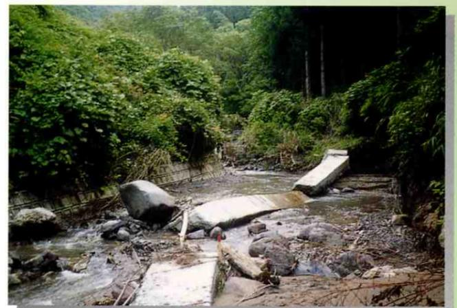
⑥ 洪水によって被災したブロック護岸
