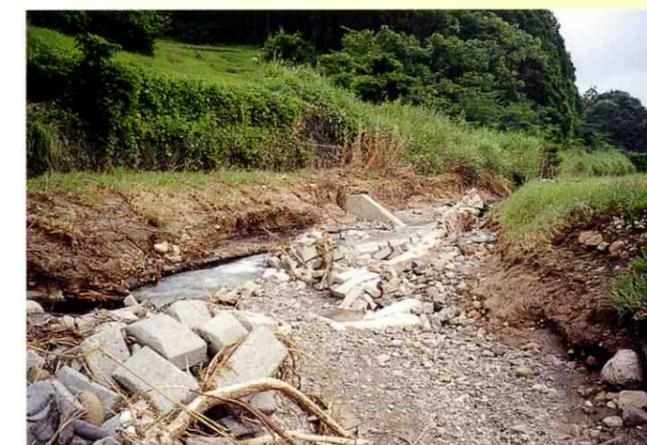
④ 洪水によって流失したブロック護岸 (山田川)
