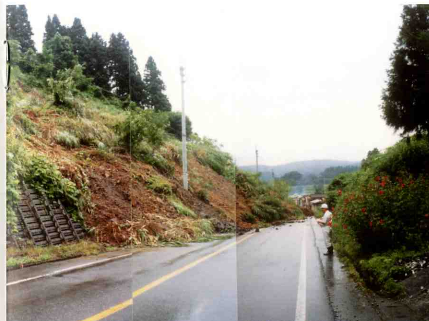
法面崩壊 国道290号(栃尾市赤谷地内)
