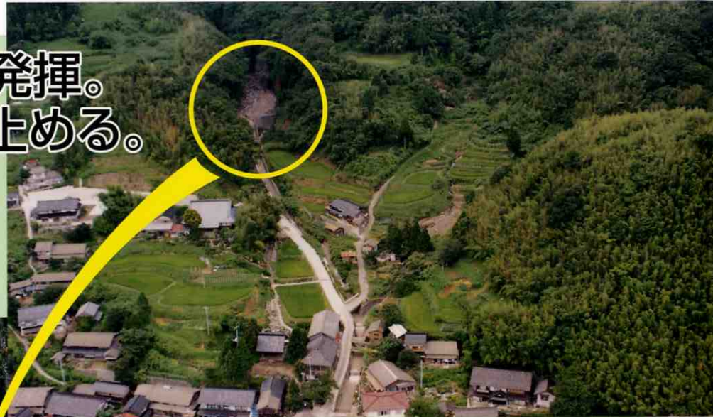
北川砂防ダムでの土砂補捉状況
