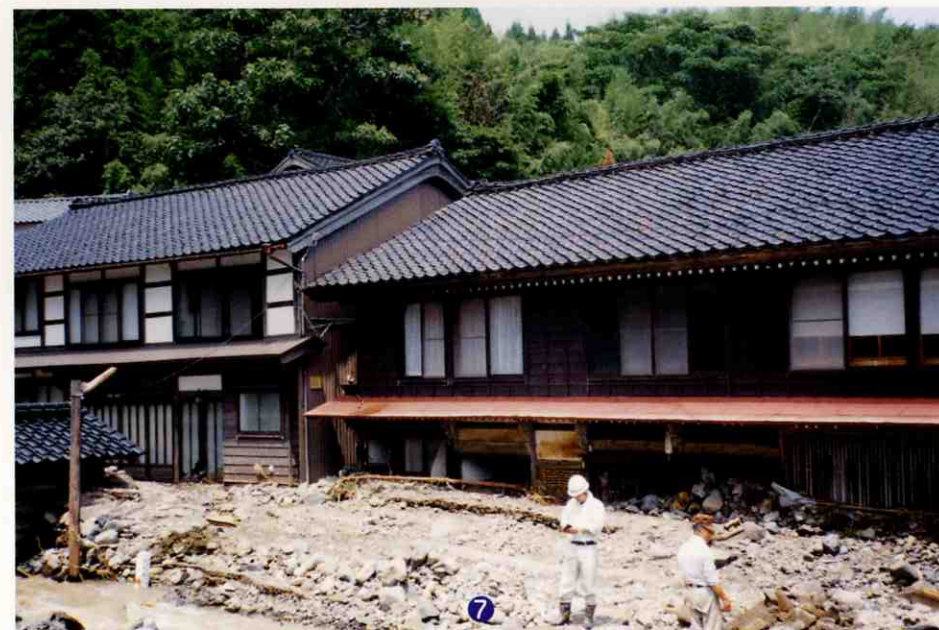
東立島川で発生した土石流により人家の2mまで土砂に埋まった(両津市東立島地内)
