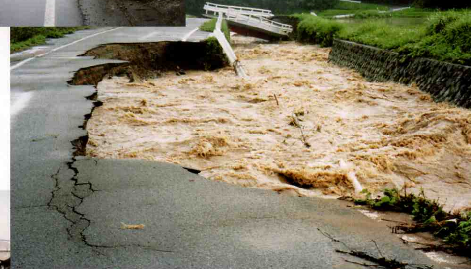
法面崩壊 国道290号(栃尾市赤谷地内)
