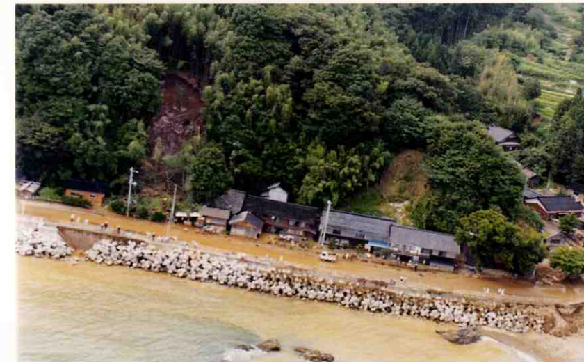
がけ崩れが発生し、人家2戸全壊1戸が半壊した東立島地区(両津市)
