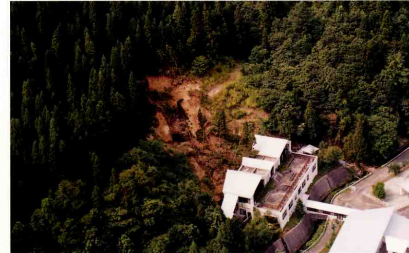
地すべりにより土砂が押し出し、「新三川温泉YOU&湯」が被災した内川地区(東蒲原郡三川村)
