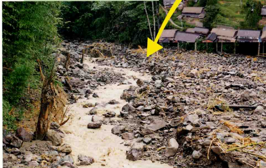
砂防ダム上流部の状況 (両津市月布施地内)
