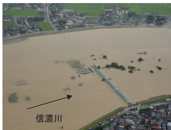
出水時の小須戸橋 撮影日:7/30
