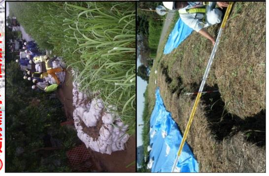
②長時間にわたる降雨及び洪水により堤体内部に残留水が生じ、堤防裏法面崩れ及び堤防漏水が生じた。
