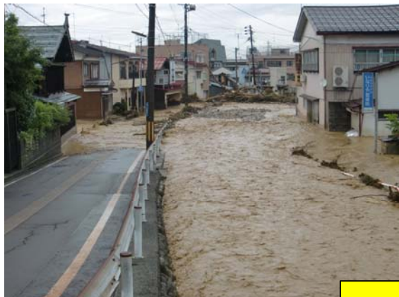
一級河川晒川（十日町市川原町）
