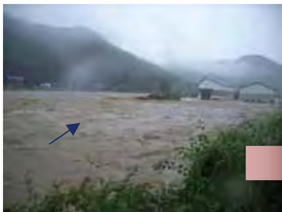
【写真下】 破間川応急工事の状況(破堤箇所) 撮影地 魚沼市長堀新田地内
