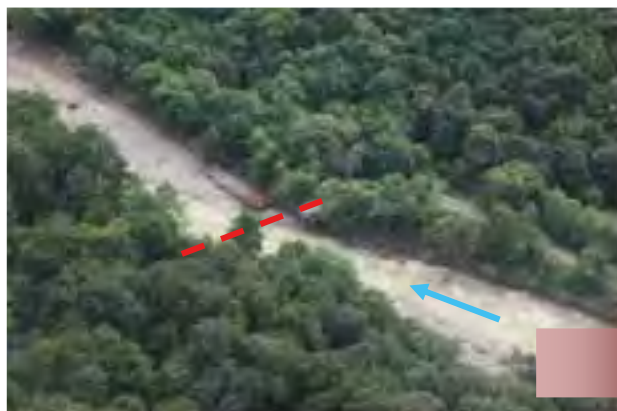
【写真下】 国道352号 金泉橋応急工事の状況 撮影地 魚沼市下折立地内
