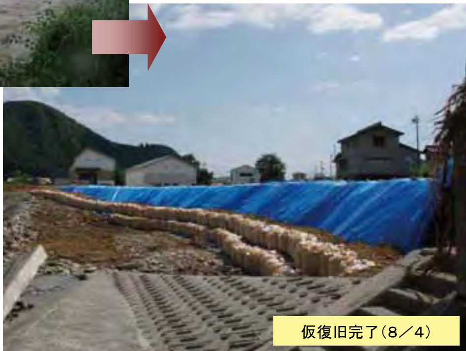
【写真下】 登川応急工事の状況(破堤箇所) 撮影地 南魚沼市大里地内
