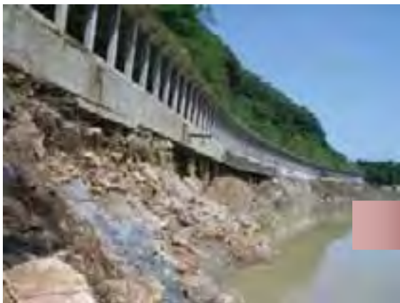
【写真下】 国道459号 師走スノーシェットの応急工事の状況 撮影地 阿賀町師走地内
