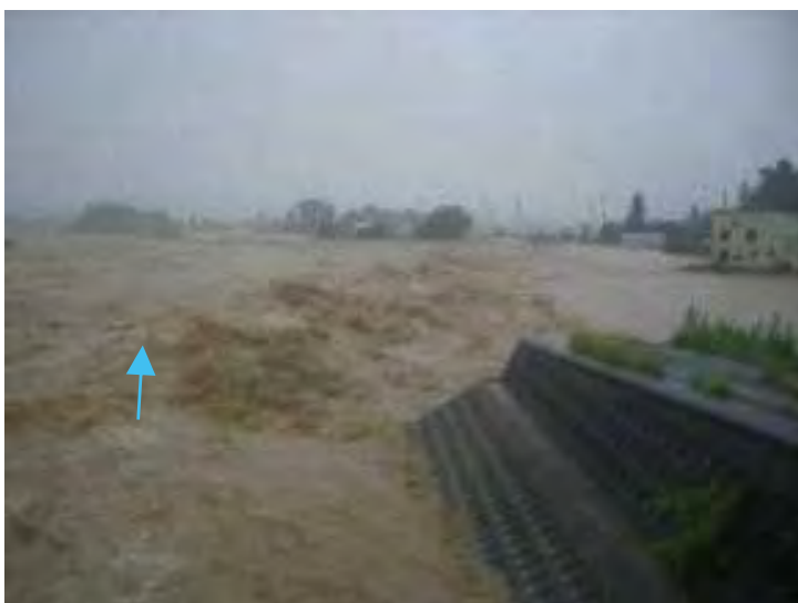
【写真左】 五十嵐川破堤の状況(上流側より) 撮影地 三条市江口地内
