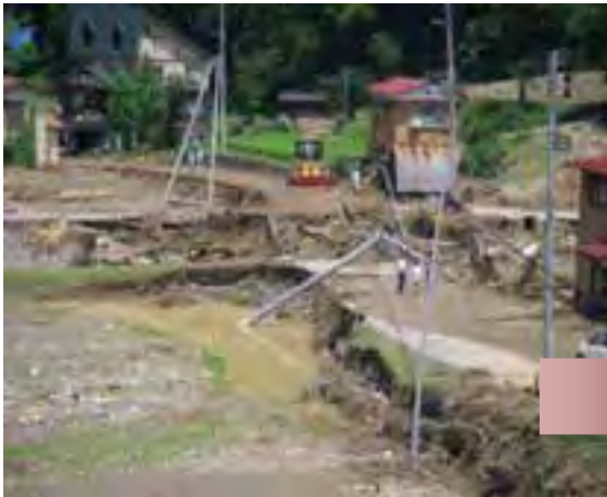
【写真下】 県道十日町塩沢線応急工事の状況 撮影地 十日町市中村地内
