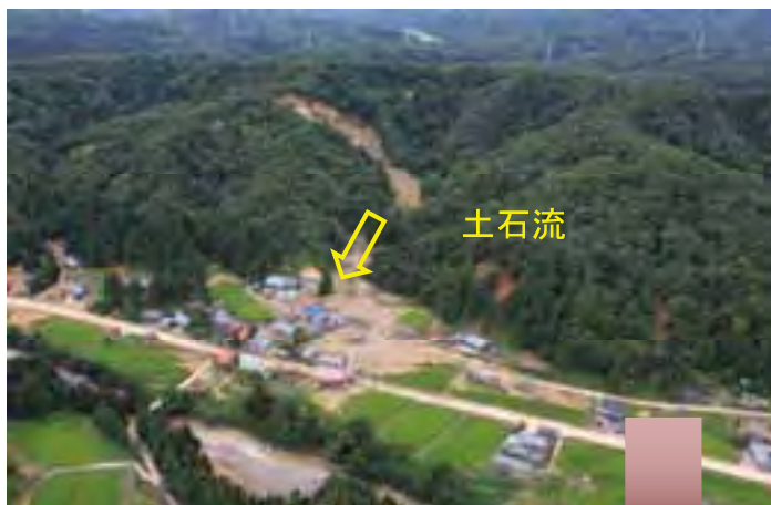
【写真下】 応急工事の状況 撮影地 三条市牛野尾地内
