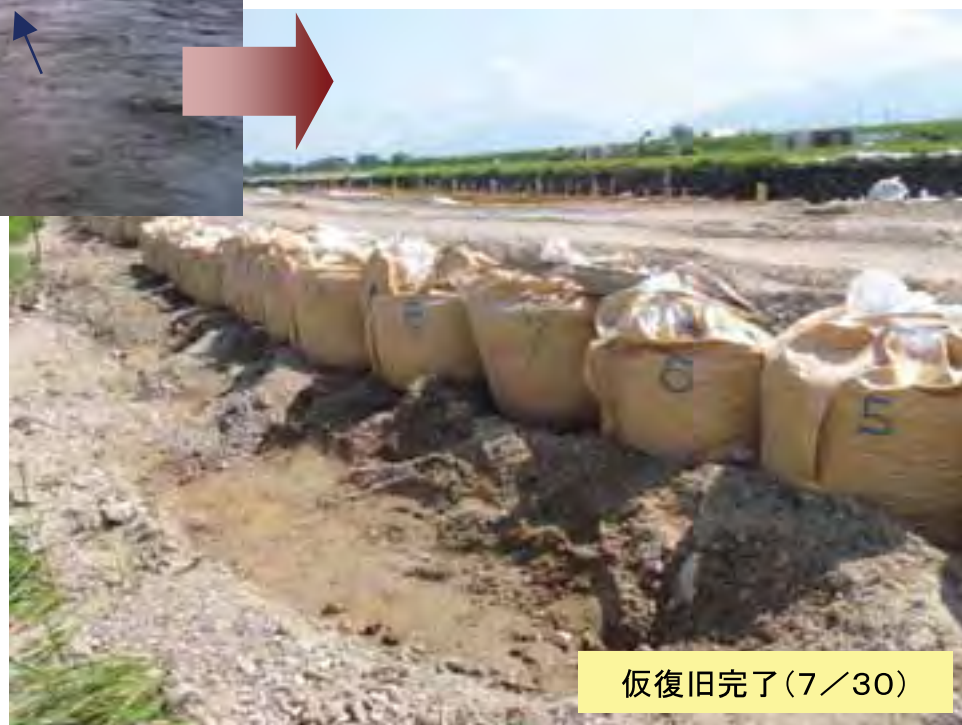
【写真下】 牧川応急工事の状況(破堤箇所) 撮影地 五泉市中野橋地内
