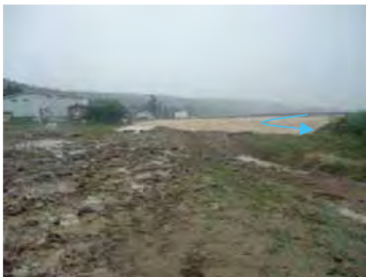
【写真右】 五十嵐川破堤の状況(下流側より) 撮影地 三条市江口地内
