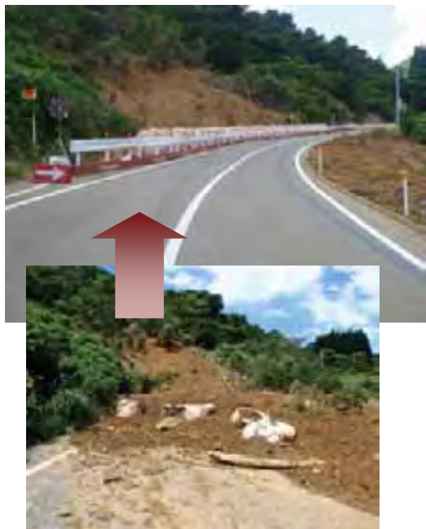
国道253号応急工事の状況 撮影地 南魚沼市余川地内 (平成23年7月31日撮影)
