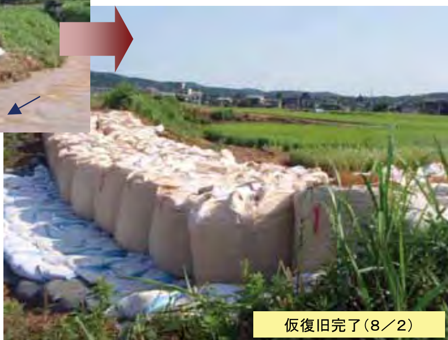
【写真下】 大平川応急工事の状況(破堤箇所) 撮影地 三条市桑切地内
