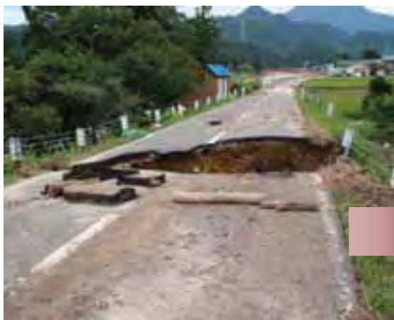
【写真下】 国道289号応急工事の状況 撮影地 三条市棚鱗地内
