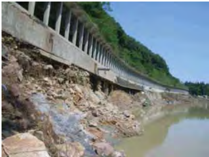
【写真左】 国道459号 師走スノーシェットの被災状況 撮影地 阿賀町師走地内
