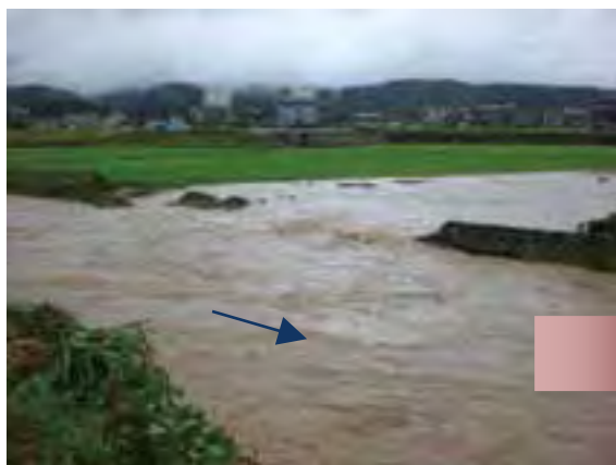
【写真下】 茶郷川応急工事の状況(破堤箇所) 撮影地 小千谷市土川地内
