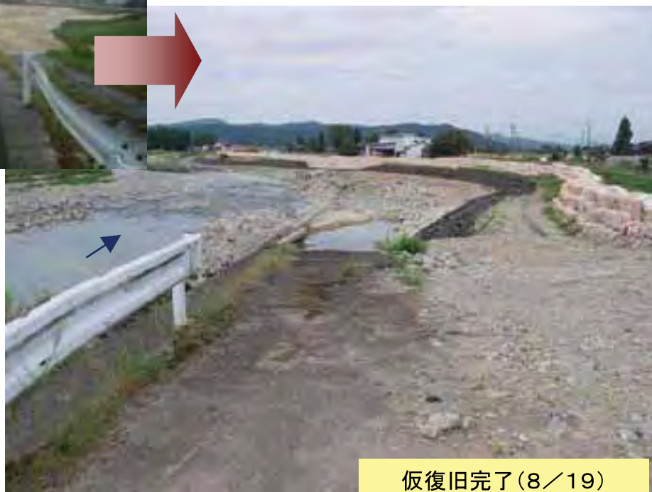
【写真下】 大平川応急工事の状況(破堤箇所) 撮影地 三条市桑切地内
