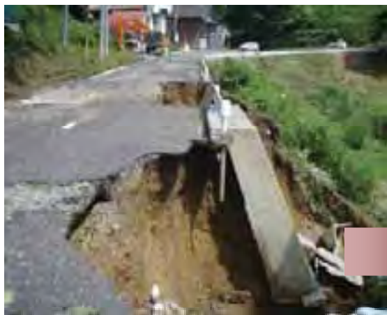
【写真下】 県道松代高柳線応急工事の状況 撮影地 柏崎市高柳町門出地内
