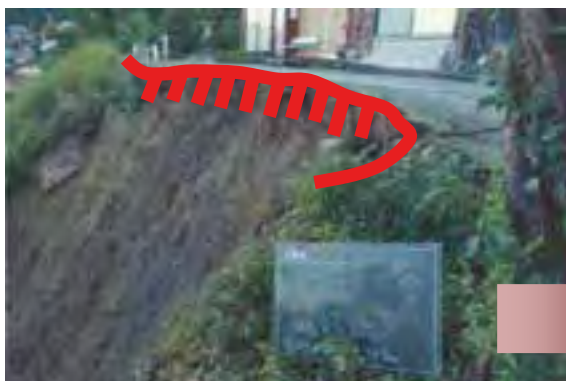
【写真下】 応急工事の状況 撮影地 長岡市栄町地内
