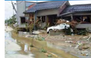
⑦旧中之島町中之島の家屋損壊状況
