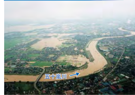
①五十嵐川の破堤状況
