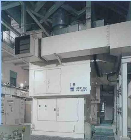
立形ガスタービンは、小型ジェット機用のジェットエンジンを改良して採用し、同出力の従来型ディーゼル機関と比べ、小型化されています。
