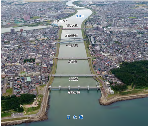
関屋分水路全景(令和3年11月撮影)
