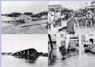
1964年6月16日の新潟地震で被害を受けた市街地
