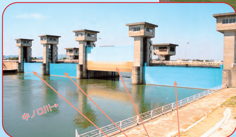
洪水制御用ゲート
