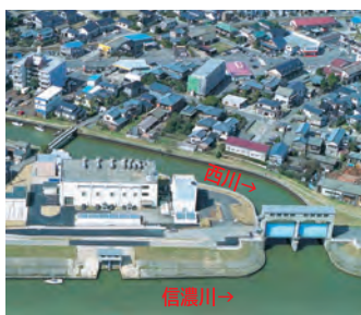
西川排水機場
