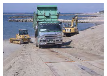
養浜状況(金衛町工区)
