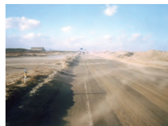
国道402号線飛砂状況（平成17年）
