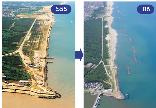
有明浜工区(離岸堤・人工リーフによる効果)
