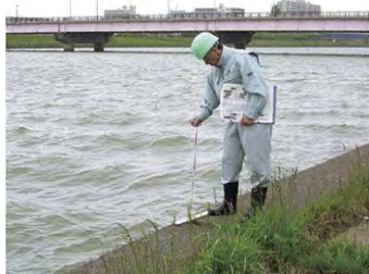
施設点検状況
