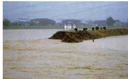
破堤した五十嵐川(平成16年7月)
