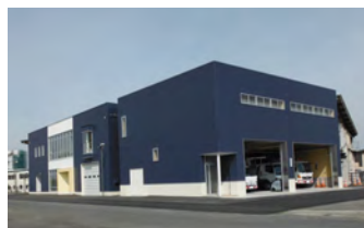
三条防災ステーション（三条MIZBEステーション） 三条市水防学習館・三条災害対策車輛庫
