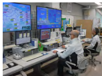
操作室（新潟大堰）
