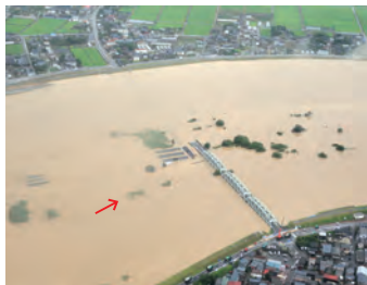
小須戸橋の状況(平成23年7月)
