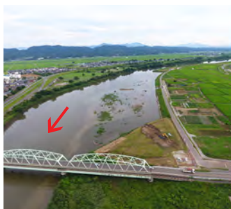
新潟市南区戸石地区 河道掘削状況
