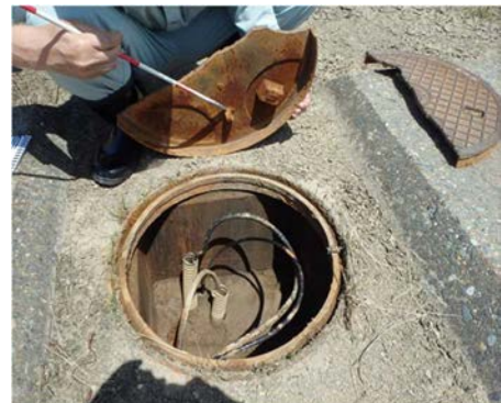
荒町水位計ハンドホール損傷状況
