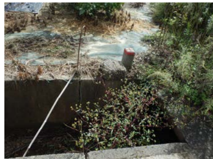
信濃川下流における堤外堤脚水路
