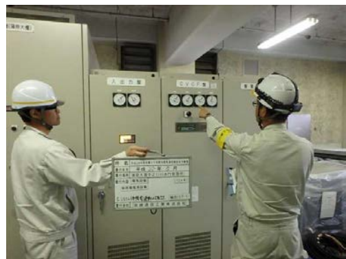
【蒲原大堰・中ノロ川水門管理所】 無停電電源設備 システム連動確認
