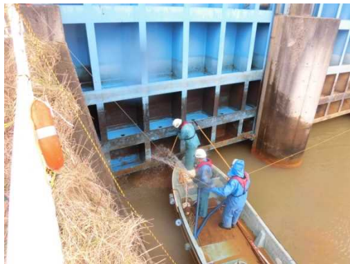
出水時操作でゲートに堆積した 土砂撤去作業
