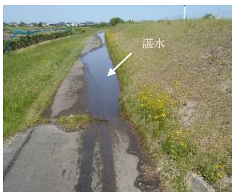
逆勾配化による裏小段の排水不良
