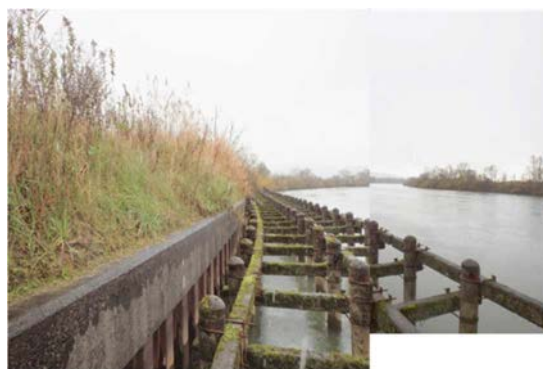
護岸前面の杭出水制
