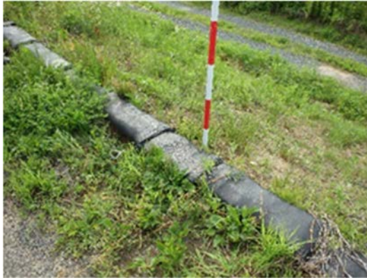
坂路肩に設置済みの枕土のう
