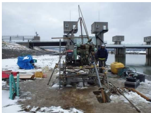
大島頭首工取水樋管での平張部空洞調査、函体基礎地盤緩み層調査
