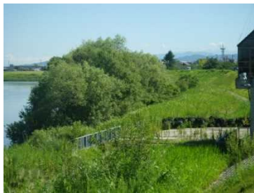
貝喰川樋門下流高木繁茂
