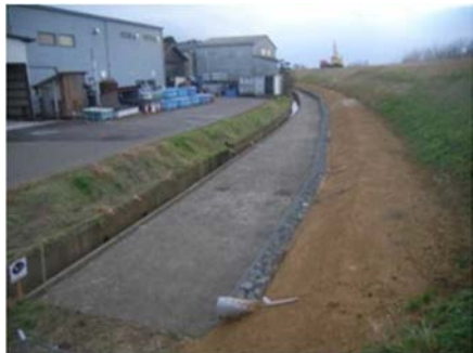
信濃川下流における堤外堤脚水路
