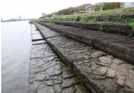
やすらぎ堤階段護岸での不陸段差、劣化損傷等
