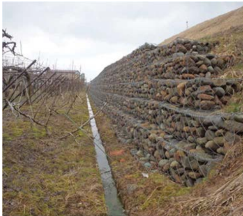
左岸井戸場地先の多段式フトン籠擁壁
