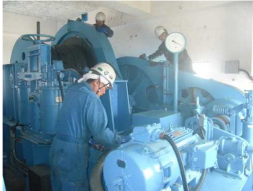
新潟大堰 主ゲート開閉装置点検
