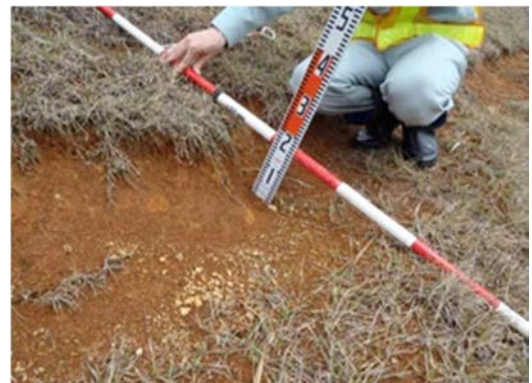
酸性硫酸塩土による植生不良と法面裸地化
