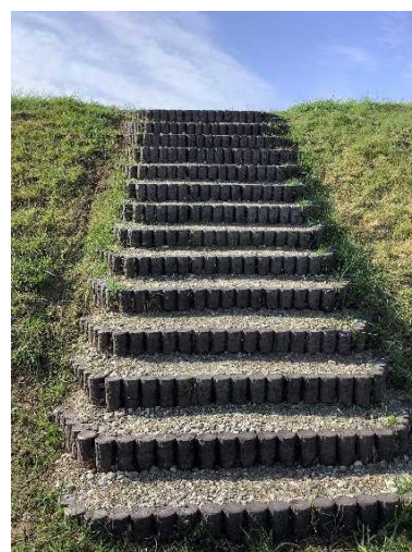
川裏階段陥没補修後
