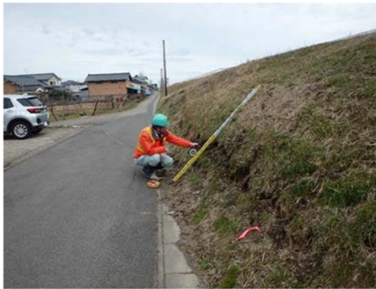
堤防裏小段法面の急勾配化
