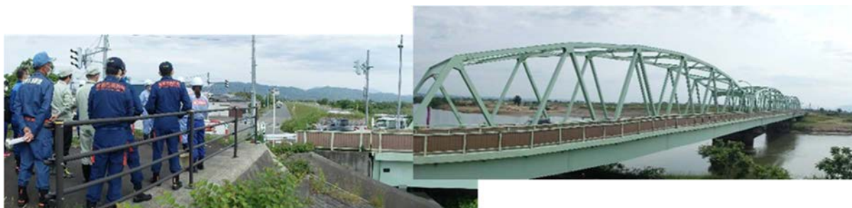
令和3年6月3日 重要水防箇所合同巡視（小須戸橋右岸にて）
