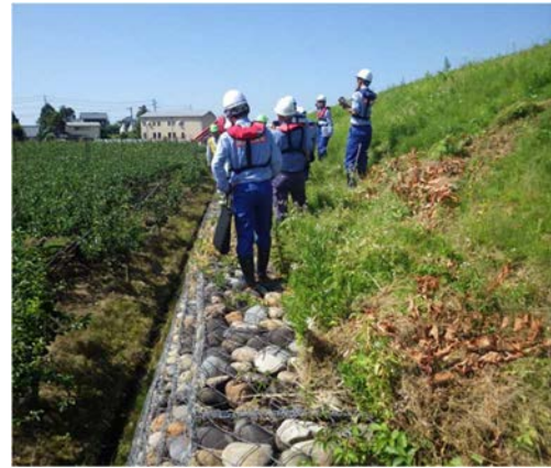
左岸井戸場地先の多段式フトン籠擁壁
