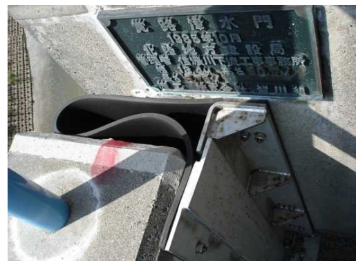
門柱継手部での水密性確保対策
