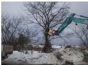
河道内樹木の伐採状況
