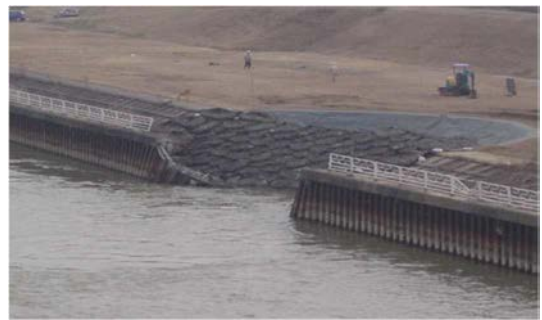
応急復旧完了（同年 3 月 9 日）
