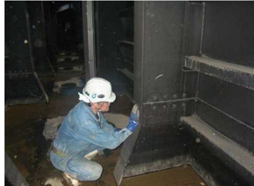
中ノロ川水門 主ゲート内部点検
