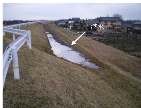
逆勾配化による裏小段の排水不良
