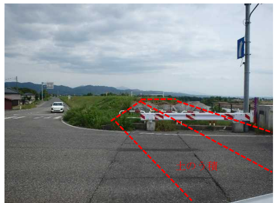
小須戸橋右岸水防箇所
