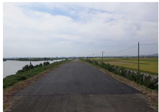
完了（最下流部）
