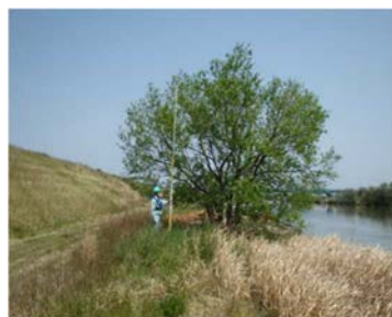
鋼矢板護岸平張上での高木生長
