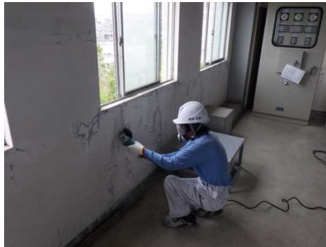
操作室壁補修
