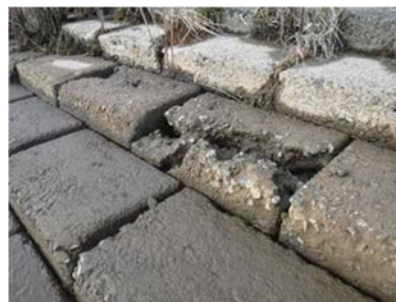
やすらぎ堤階段護岸での不陸段差、劣化損傷等
