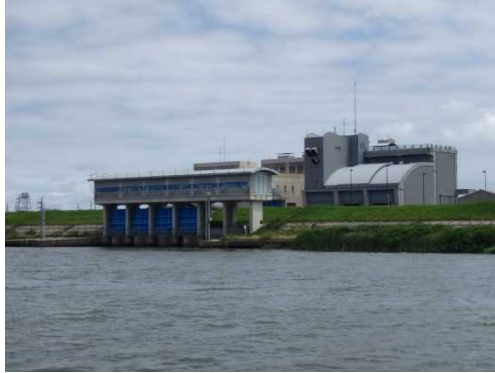
鳥屋野瀉排水機場
