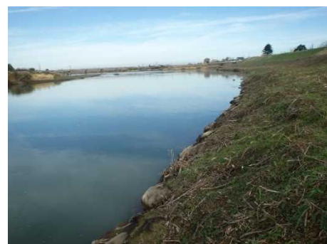
護岸先端に敷設された袋詰め玉石工
