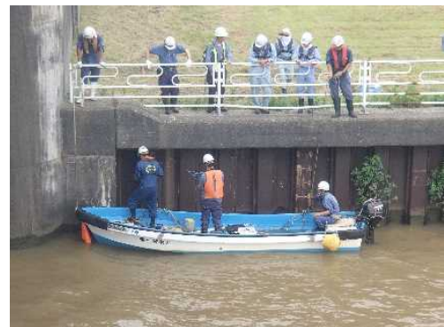
中ノ口川水門 下流 鋼矢板護岸 詳細調査の様子
