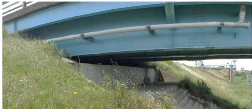
信濃川大橋左岸特殊堤（直立式高さ 1.0m）
