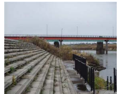
防災船着場階段護岸
