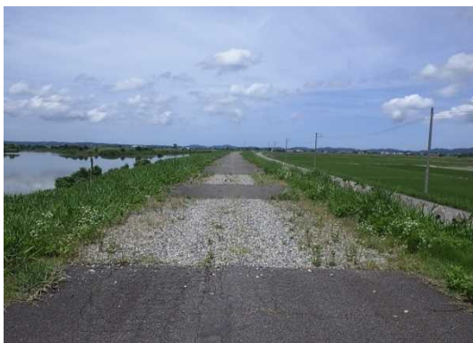
着手前（最下流部）
