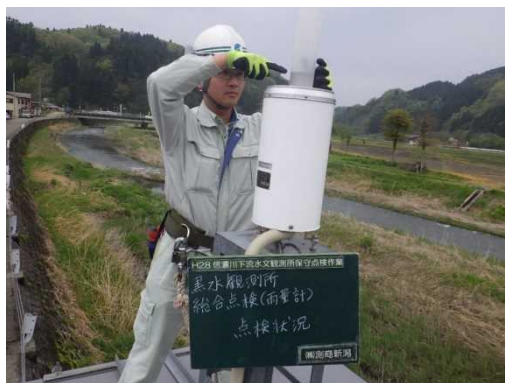
雨量観測所 総合点検
