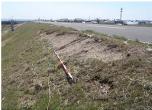
酸性硫酸塩土による植生不良と法面裸地化
