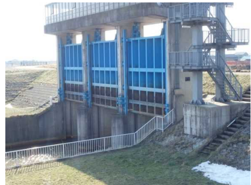
土砂撤去作業完了
