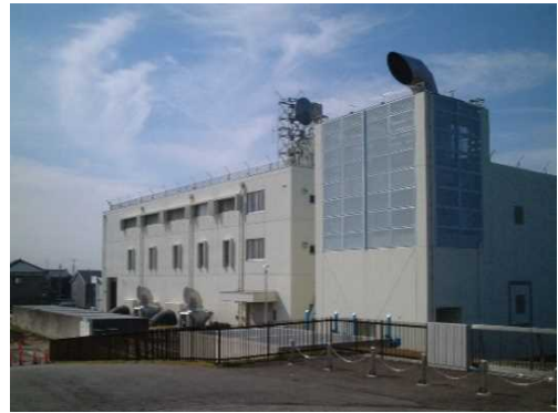
西川排水機場
