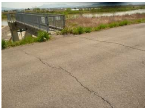
赤渋取水樋管
