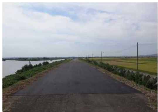
完了（最下流部）
