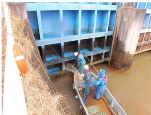
出水時操作でゲートに堆積した 土砂撤去作業
