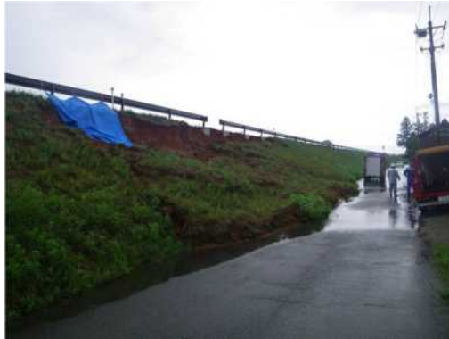
急傾斜堤防法面の平成23年7月豪雨による斜面崩壊 (本川 R22.2K～22.6K)
