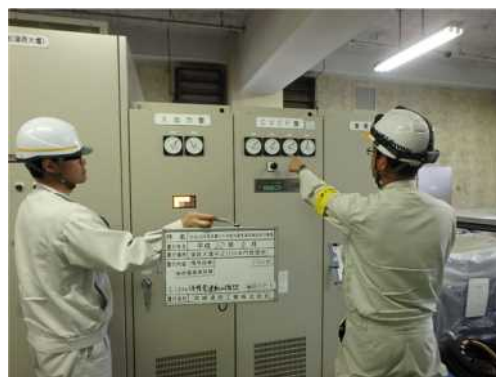
【蒲原大堰・中ノ口川水門管理所】 無停電電源設備 システム連動確認
