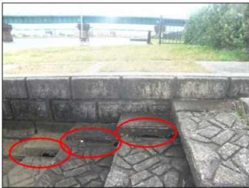
階段ブロックにて段差発生
