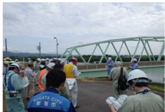
平成 28 年 5 月 26 日（木）に 実施された巡視点検の様子
