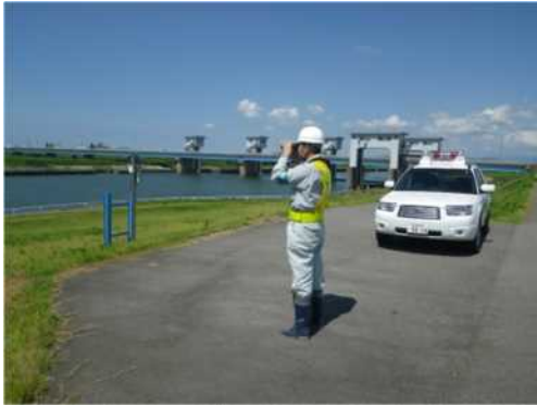
車両による一般巡視 (蒲原大堰付近)
