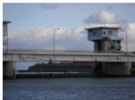
外ケーブル補修後
