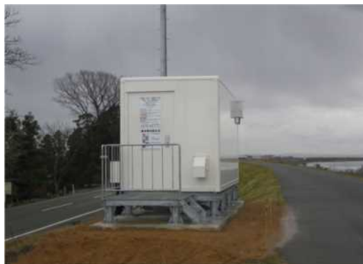
水位観測局舎
