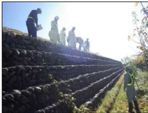
軟弱地盤に設置された堤脚保護工 (井戸場地区)
