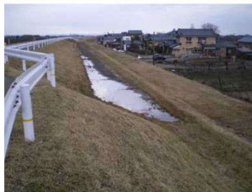
逆勾配化による裏小段の排水不良
