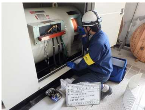
【信濃川水門】 ガスタービン発動発電機動作点検
