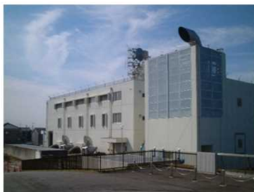
西川排水機場
