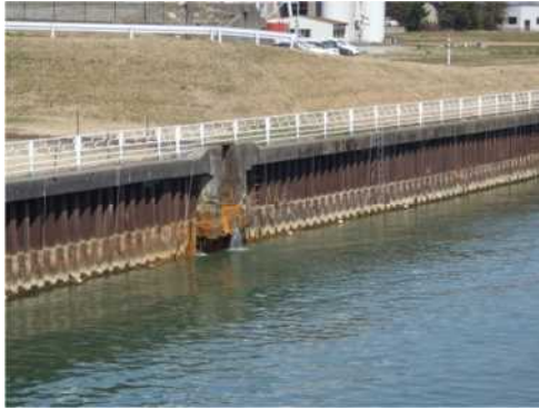
中ノロ川水門 下流 鋼矢板護岸 詳細調査の様子
