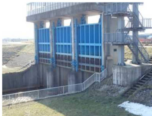
土砂撤去作業完了
