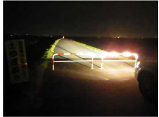
夜間の一般巡視 (堤防天端 管理用通路)
