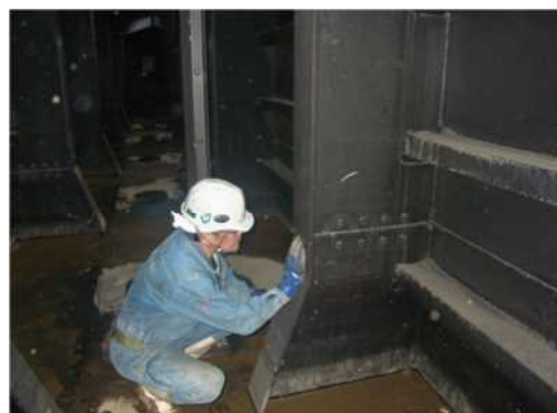
中ノロ川水門 主ゲート内部点検
