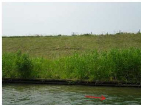
信濃川左岸 49.0 km + 170m 笈ヶ島川表法面亀裂
