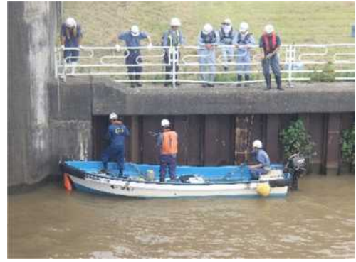
中ノロ川水門 下流 鋼矢板護岸 詳細調査の様子
