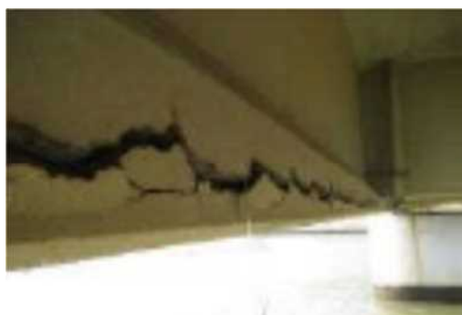
主桁の損傷状況
