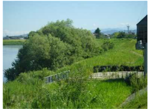
貝喰川樋門付近
