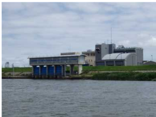
鳥屋野潟排水機場
