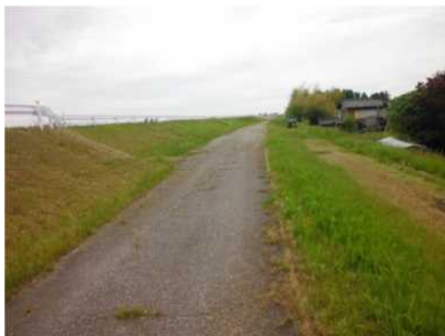
裏小段（旧堤部）の逆勾配化 （堤防法尻部の弱体化が懸念）
