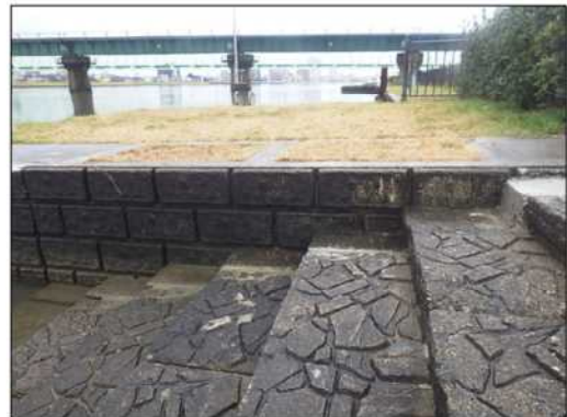
階段ブロックの段差解消
