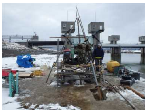
大島頭首工取水口樋管付近 空洞状況詳細調査
