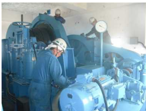
新潟大堰 主ゲート開閉装置点検
