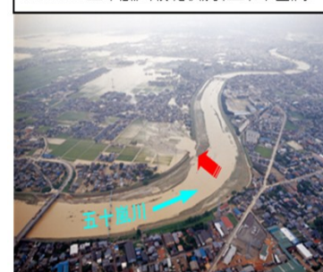
H16.7.13 五十嵐川破堤状況(三条市曲淵)
