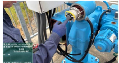
下八枚雨水排水樋門 開閉装置点検
