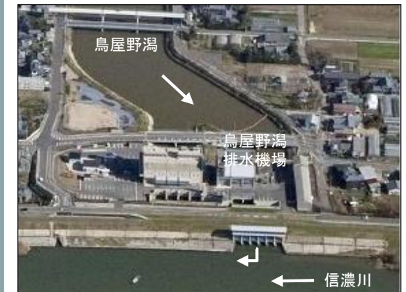
鳥屋野潟排水機場
