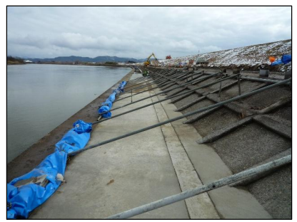
護岸補修作業
