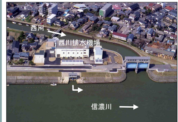
西川排水機場
