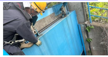
山田川樋門 扉体点検
