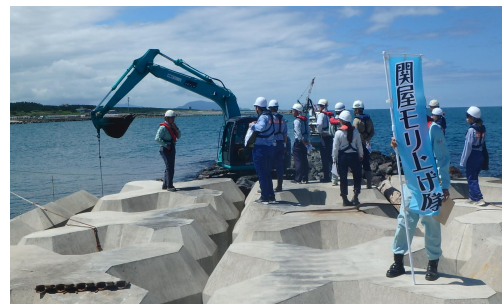
海岸工事現場見学
