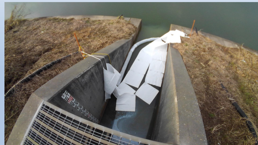
オイルマットやオイルフェンスにより、水路の油膜を吸着している様子
